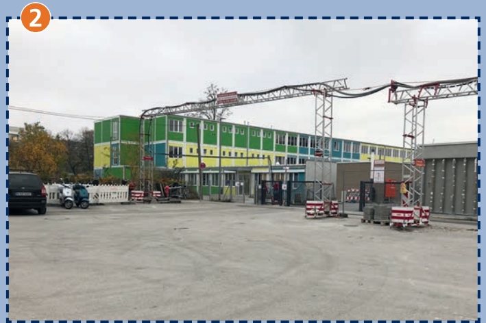
Wendehammer an der Gertrud-Grunow-Straße 51
